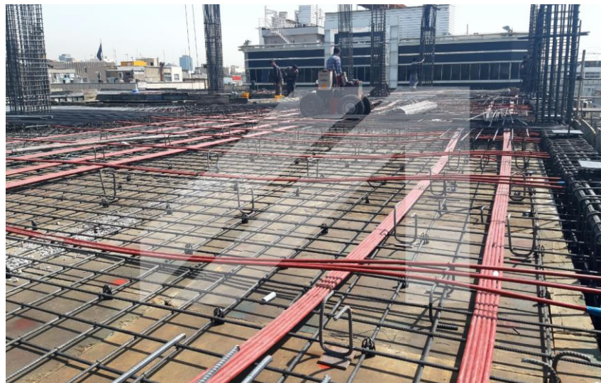
شکل (۵) چیدمان دوطرفه تاندون ها در سقف پیش تنیده
