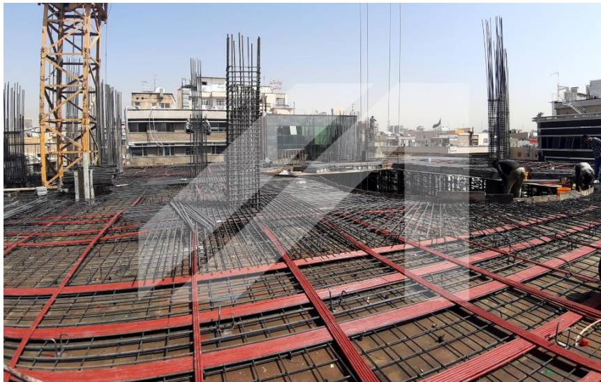
شکل (۴) پروژه گلدن مال ، آرماتوربندی در یک لایه مش تحتانی
