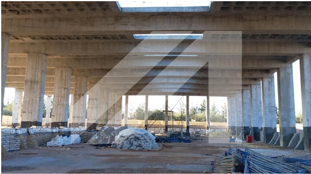
شکل (۷) سقف وافل پیش تنیده با دهانه ۲۶ متر در پروژه کارخانه میکرونیج کویر یزد
